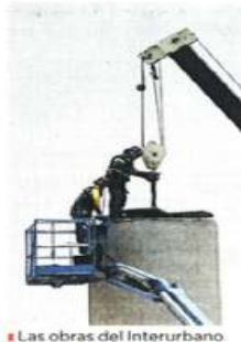
■ Las obras del Interurbano suman más de 10 años.
