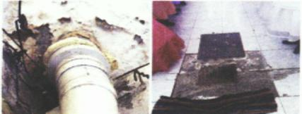
El techo tiene huecos por donde entra el agua de lluvia; las filtraciones de las tuberías son evidentes y las coladeras presentan desgaste.
