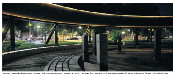
Hay problemas con el contrato con CFE, por lo que el memorial no tiene luz, señalan.
