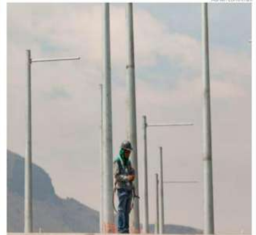
En la estación Santa Marta el tendido del cableado eléctrico es uno de los pendientes de la obra.
