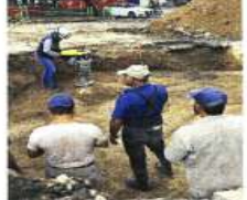
En la zona, trabajadores laboran para rellenar el hoyo.
