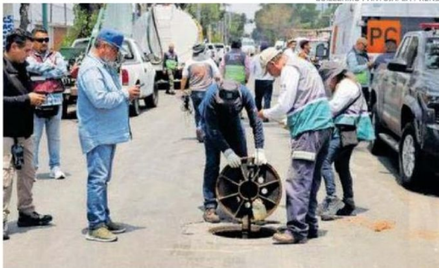
Personal de Protección Civil revisa el alcantarillado con un explosímetro
