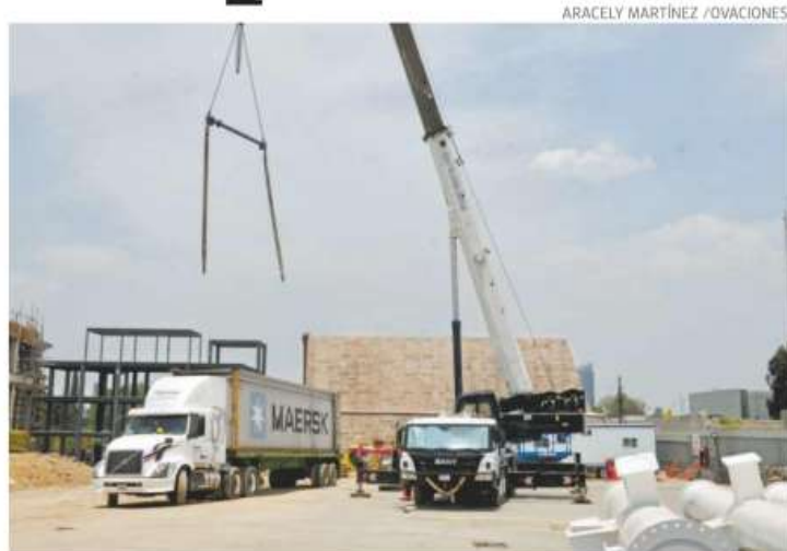
Todas las cimentaciones, estructuras y juegos son completamente nuevos
