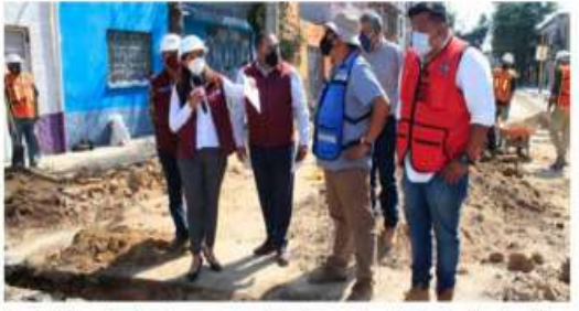
La alcaldesa, Evelyn Parra, supervisó obras en la colonia Águiles Serdán.
