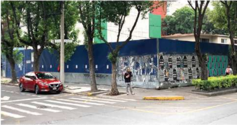
EL PREDIO en donde se tiene proyectado construir una escuela, en Galileo 307, lució tapiado, ayer.
