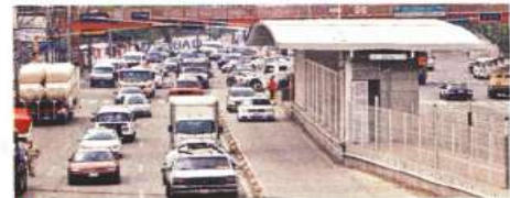
La obra, en el Estado de México, pudo terminarse en año y medio, pero ya acumula casi 5 años de retraso.
