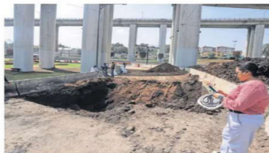
Se procederá a construir una caja disipadora para contener y mantener la estabilidad del terreno donde se encontraba la grieta: Segiagua.
