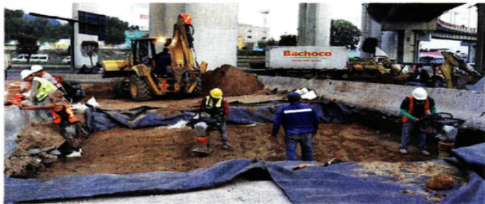
Personal de Segiagua supervisa las labores de relleno de la grieta en el bajopuente.
