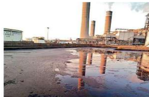
La Central Termoeléctrica Plutarco Elías Calles, ubicada en el municipio de La Unión, Guerrero, registró la semana pasada un derrame de aceite que llegó hasta la bahía.
