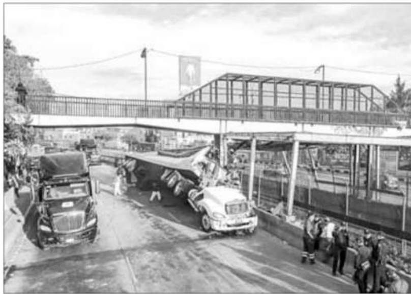
◀ Cientos de usuarios de la línea 5 del Metro resultaron afectados debido a la volcadura de un tráiler la madrugada de ayer cuando circulaba por Circuito Interior. La pesada unidad afectó el muro perimetral, la malla ciclónica y las bandejas del cableado. Foto Alfredo Domínguez
