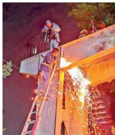
Los trabajadores llevaron a cabo diversas maniobras para realizar el retiro de una estructura del Metro, conocida como rampa antisúidicios
