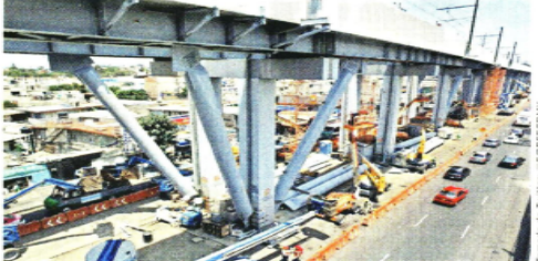
Una trabe del tramo elevado de la Línea 12 del Metro se desplomó el 3 de mayo de 2021.
