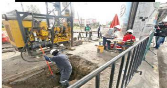
Trabajadores y peritos perforaban el suelo debajo del viaducto elevado para realizar estudios de geotecnia.
