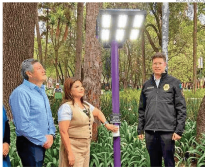
Clara Brugada pone en marcha Ciudad Iluminada: Camina Libre, Camina Segura
