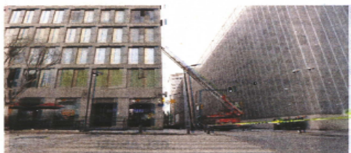
Después de las 15:00 horas, la acumulación de gas provocó una explosión en un departamento del octavo piso. Cayeron cristales a la acera.
