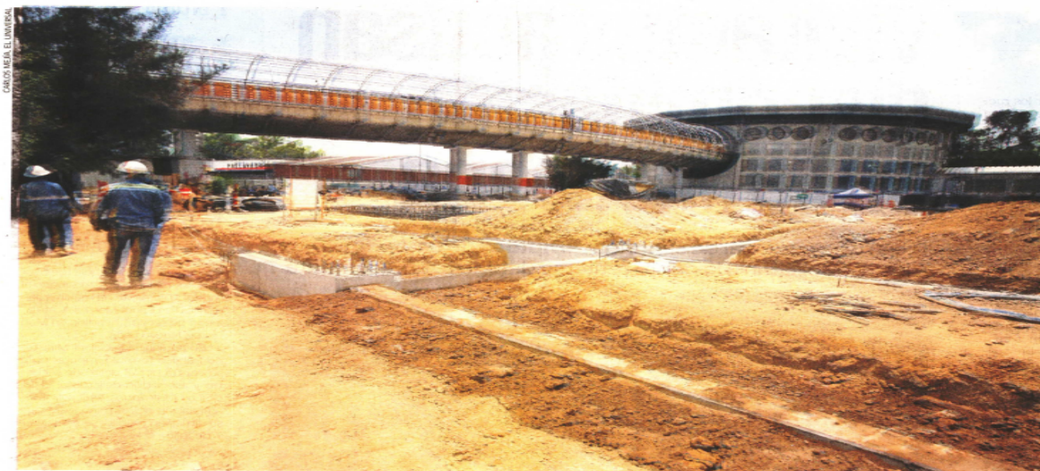
Actualmente, en el Cetram San Lázaro se trabaja en la cimentación y montaje de estructura metálica, según se observó en un recorrido.
