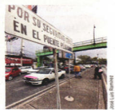
■ Una señalización invita a cruzar por el puente; este no cuenta con accesibilidad universal.
