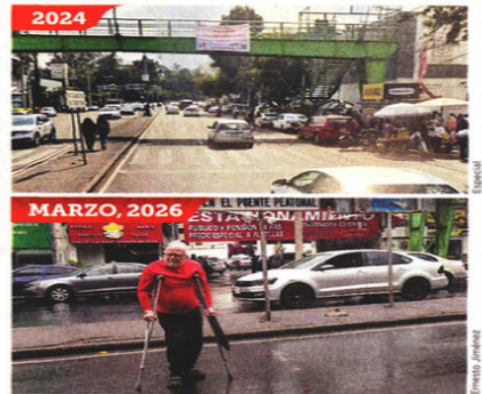
■ Pacientes con movilidad limitada cruzan por lo que alguna vez fue el paso peatonal, ante la inaccesibilidad del puente.
