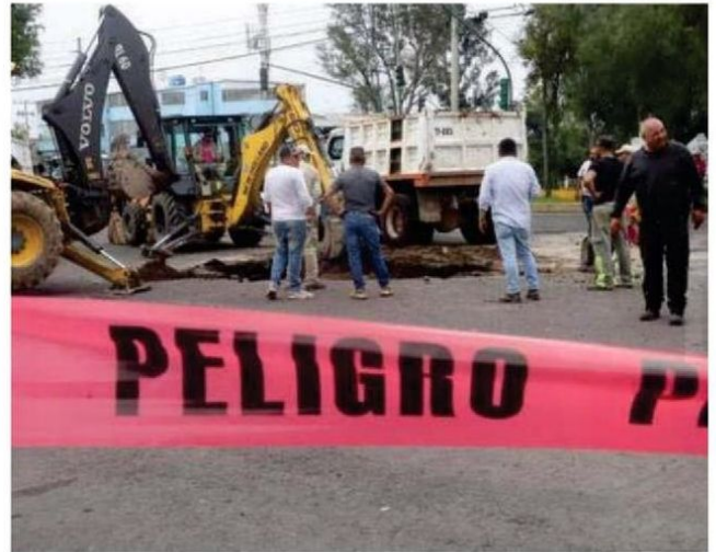
Los vecinos de la zona observaban muy atentos los trabajos que realizaba el personal de la Secretaría de Obras y Servicios para sacar el fango y rellenar con grava
