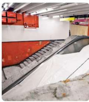
LABORES. En un recorrido realizado por este diario se constataron los avances en el retiro de losetas, vías, balasto y sistemas eléctricos en Pino Suárez.
