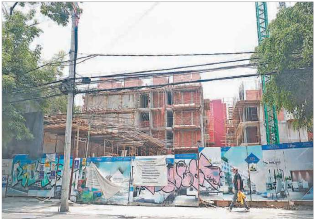
▲ La Fiscalía capitalina cuenta con pruebas sólidas de que en Benito Juárez se otorgaban permisos de construcción a cambio de departamentos, asegura la jefa de Gobierno. En la imagen, desarrollo habitacional sobre la avenida Coyoacán. Foto Luis Castillo
