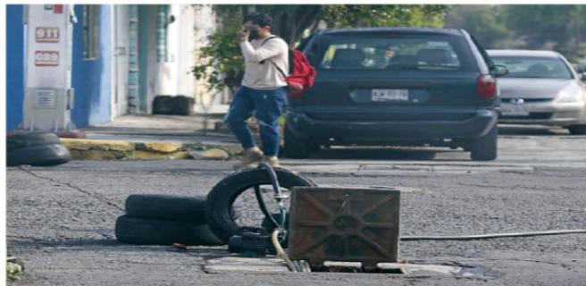
En la red hidráulica se han detectado tomas clandestinas en las que se instalan mangueras y bombas para llevar el agua a puntos de almacenaje.
