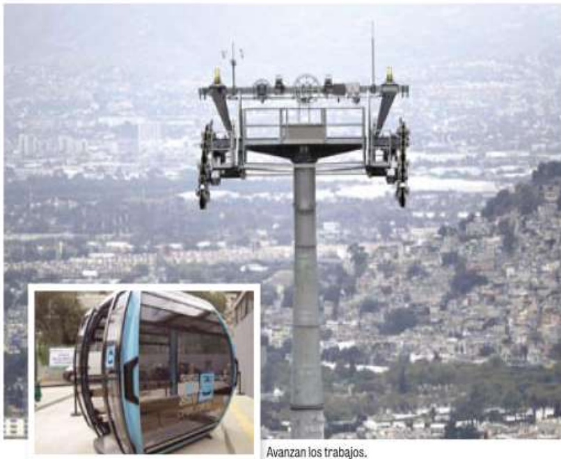
Avanzan los trabajos.
