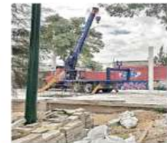
Vecinos de AO se han opuesto a la construcción del proyecto.
