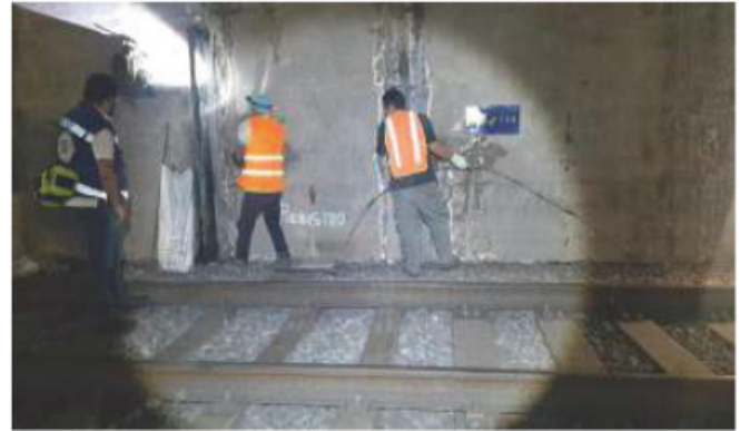
LOS TRABAJOS de desazolve de tubería en el túnel sólo se han completado en dos estaciones.
