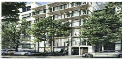
Vecinos denunciaron que fueron construidos pisos extra en Oaxaca 33 sin los permisos legales.
