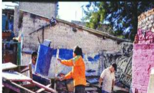
Las casas irregulares se asientan en 6 mil metros cuadrados.
