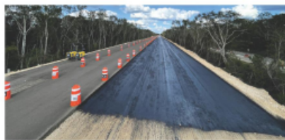
Trabajos en la vía Izamal-Cancún.
