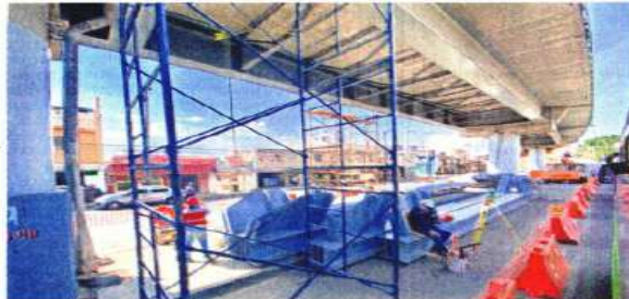
Via transparencia, la Sobse expuso que las más de 13 mil toneladas de acero se han utilizado entre las estaciones Zapotitlán-Lomas Estrella de la Línea Dorada.
