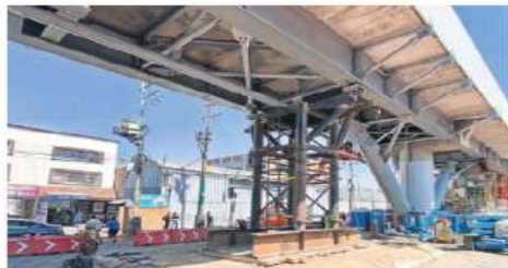
Las 13 mil toneladas de acero se han utilizado para rehabilitar el tramo elevado de la Línea Dorada que colapsó en mayo de 2021.
