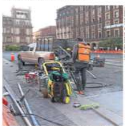
Cuadrillas trabajan en el circuito sobre los arcos de joyerías.
