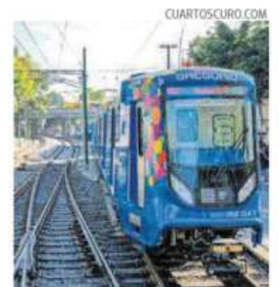
Se sigue renovando la infraestructura.
