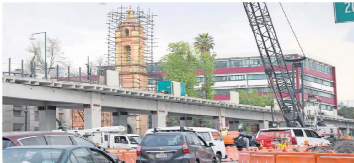
En un tramo del Parque Elevado ya se colocó la estructura para el barandal.
