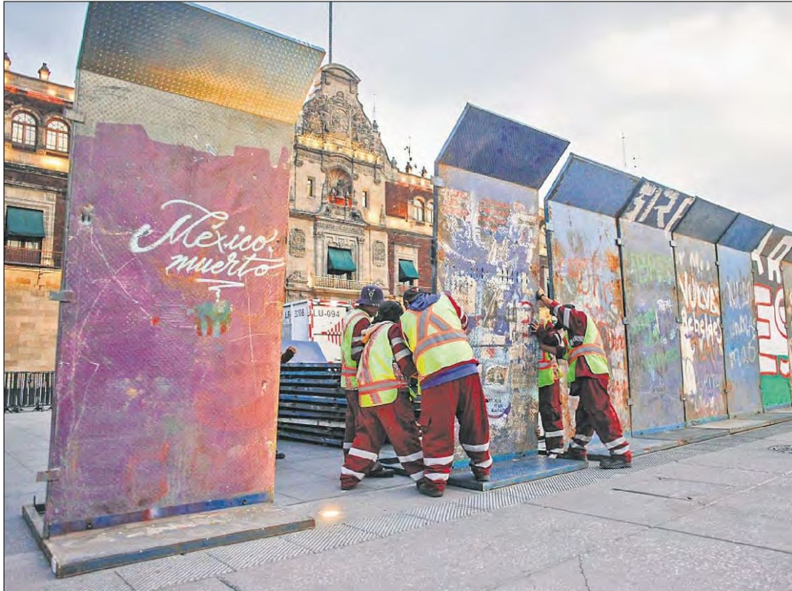
▲ Las estructuras metálicas tienen una altura de tres metros. Foto Víctor Camacho
