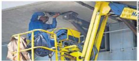
Las labores que se realizan son de soldadura y colocación de placas metálicas debajo de las traveses que cargan el Trolebús.
