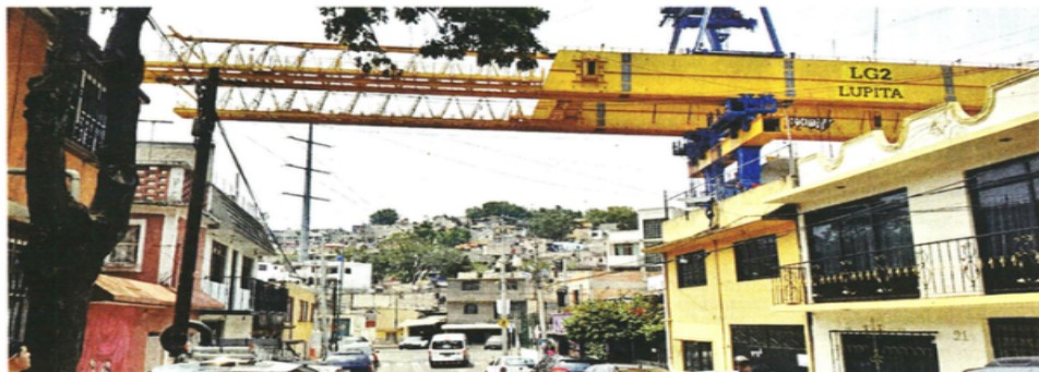
SUSPENSO. La maquinaria imponía, pero después de que se desplomó otra similar, atemoriza. Por ahora no tiene actividad.
