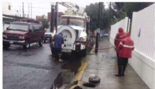
La CAEM desplegó personal y maquinaria especializada para dar atención en las zonas afectadas.
