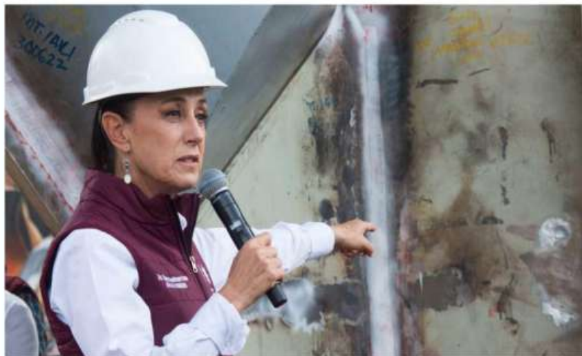
La mandataria capitalina realizó un recorrido de supervisión de las obras de rehabilitación de la Línea 12. Cuartoscuro
