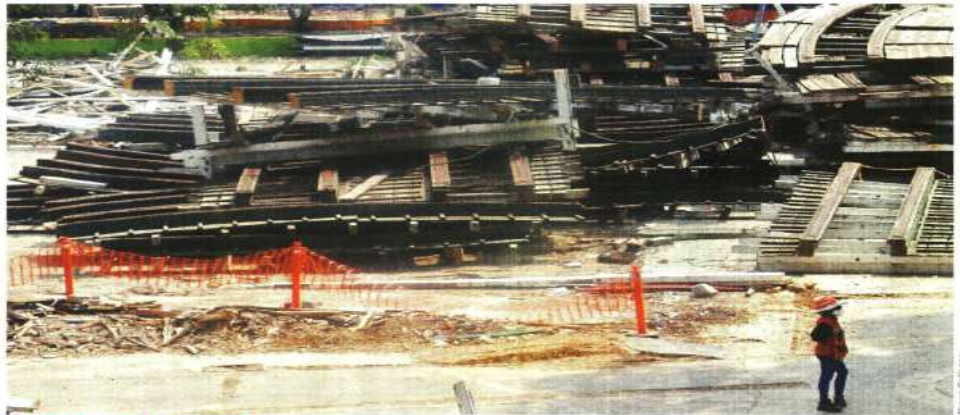
DESMONTAN LA HISTORIA. Los 240 metros de recorrido de la Montaña Rusa fueron desmantelados en una operación que se extendió a lo largo de tres meses y que generó 21 toneladas de residuos.
