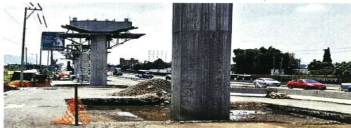
HALLAZGO. Durante los trabajos de perforación, parte del biogás acumulado comenzó a emanar.
