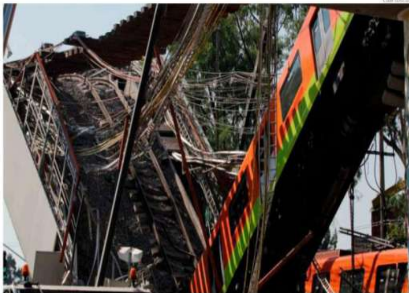
La tragedia ocurrió el pasado 3 de mayo, cuando colapsó un puente elevado de la Línea 12.
