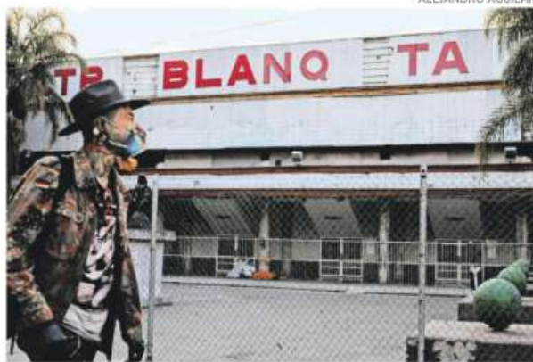
Una malla en mal estado mantiene cercado el recinto
