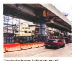
Trabajadores laboran en el reforzamiento de las columnas.
