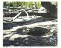
Personal del Sacmex acudió ayer a evitar la pérdida del líquido.
