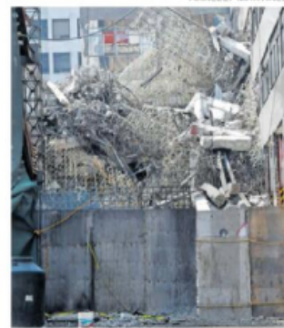
Los trabajos en el edificio siguen suspendidos.
