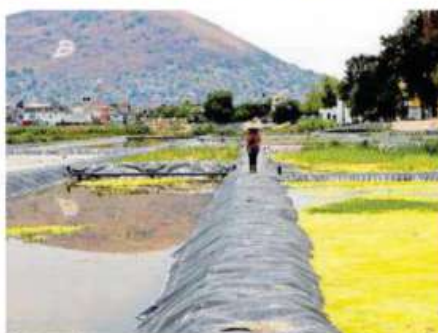
Esta es la zona donde se trata el agua
