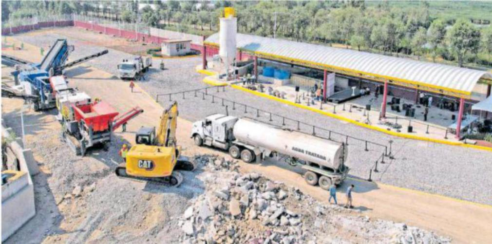
La planta trituradora cuenta con una superficie de terreno de 7,500 metros cuadrados, se construyeron 3,500 y tiene una capacidad para procesar 600 metros cúbicos al día de concreto ecológico /CORTESÍA: GCDMX
