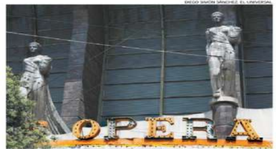
El Cine Ópera fue inaugurado en 1940 en la colonia San Rafael, Ciudad de México. Destaca por su estilo art deco. Actualmente se encuentra abandonado.
