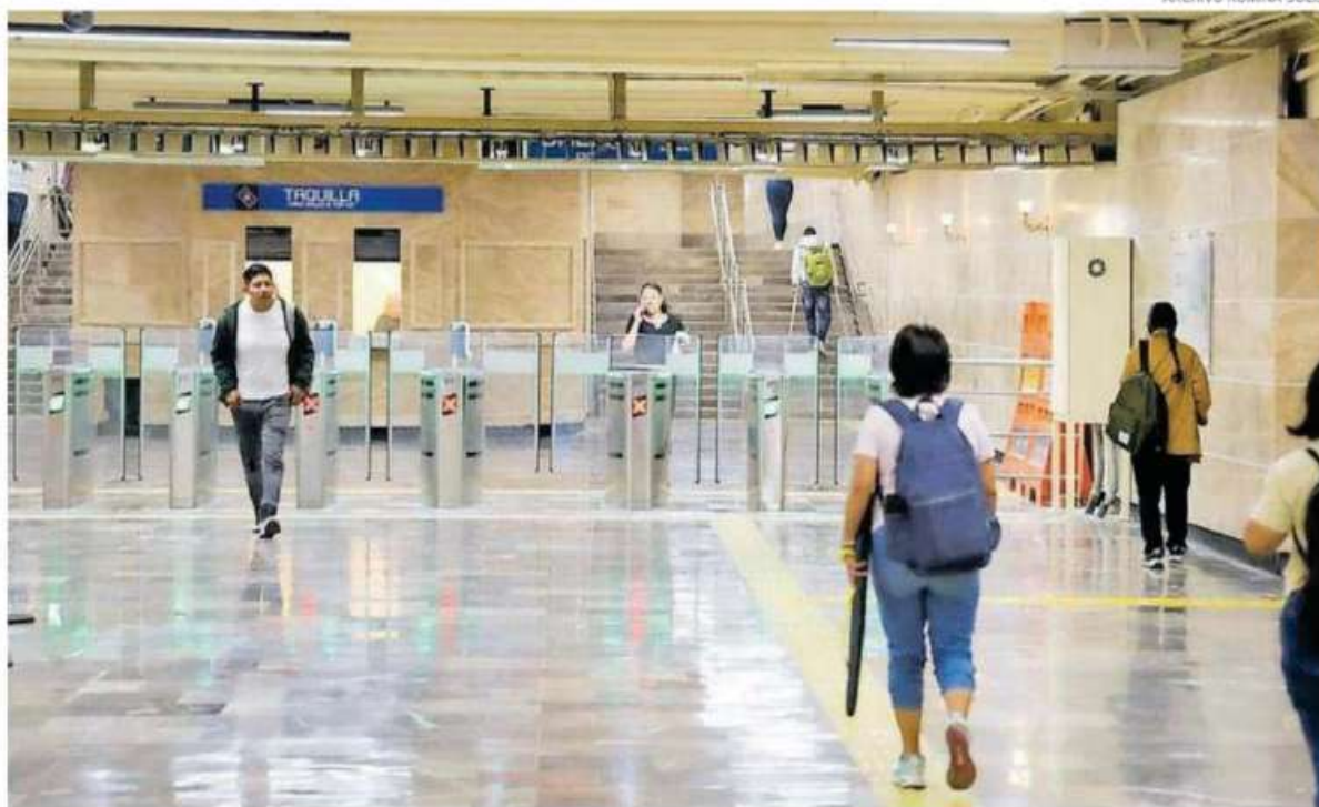
Puertas automáticas instaladas en la estación Hidalgo
