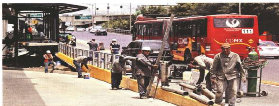
En la estación Motezuma, ayer se colocaban barandales y cristalería. Hoy comienza a operar la ampliación en la Línea 5.
