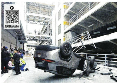
TOLDO AL PISO. La camioneta se vino abajo tras derribar la valla de contención.
