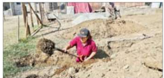
▲ Cargar tabiques o bultos de cemento no fue obstáculo para que María Santos desempeñe un oficio que ama: la albañilería. Foto Luis Castillo
