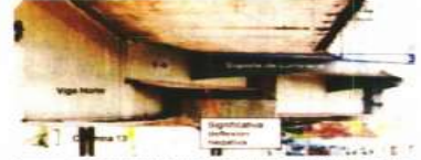
Imágenes que muestra una importante deflexión negativa en la viga norte y T-6 entre las columnas 12 y 13.
