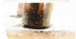
Las imágenes de arriba detallan pernos mal soldados.
