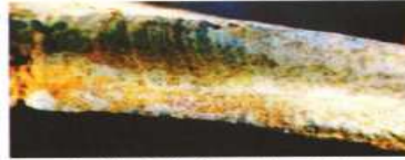
Marcas de fatiga de la grieta a lo largo de la superficie de la fractura en el alma de la viga T-6.
