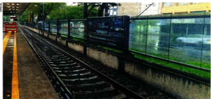
Tras la caída de un rayo en la catenaria de la estación Xotepingo, el Tren Ligero suspendió el servicio en varias estaciones, unidades de RTP brindaron apoyo a usuarios.
