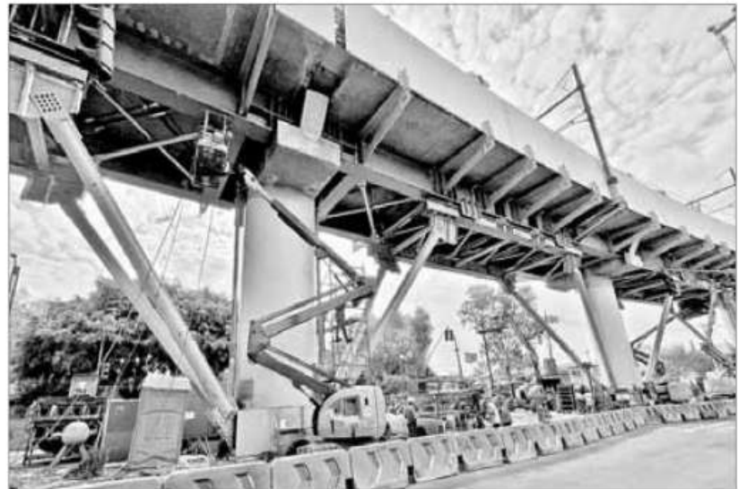
▲ El defensor de los afectados por el accidente señala que no han aceptado ningún acuerdo reparatorio por "no estar apegado a la realidad de sus necesidades". En la imagen, trabajos de refuerzo en la zona de San Lorenzo Tezonco. Foto Marco Peláez
