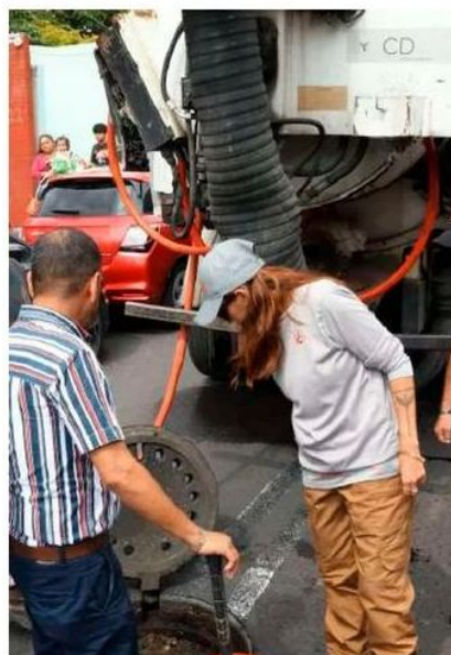
Evelyn Parra Álvarez dotó de herramienta necesaria a las cuadrillas y destacó que el principal objetivo es evitar que el agua ingrese a las viviendas.
